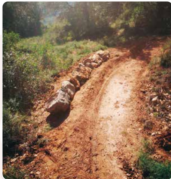
Inici de construcció d'un peralt
